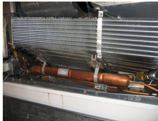
Gereinigter und desinfizierter Verdampfer
