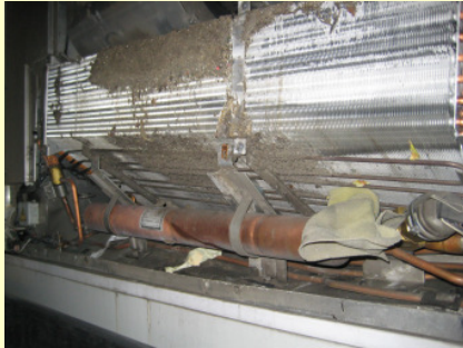
Verschmutzter Verdampfer
